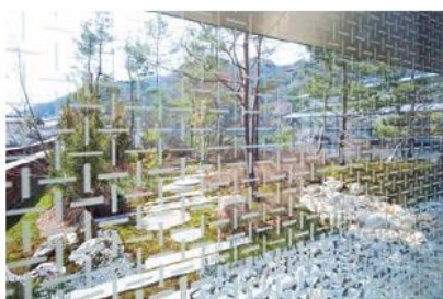
13: 「網代文様」の外壁ガラス
